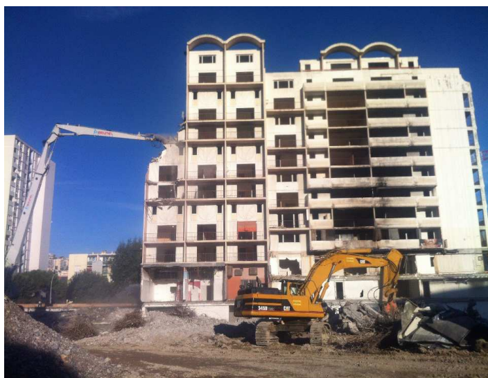
Avancée de la destruction de la Tour 30, symbole des « Moulins » à Nice, le 19 novembre 2014, © Laura Giraud
